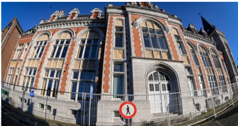
Toute la façade de l'aile le long de la place Paul Janson va devoir être sécurisée.
