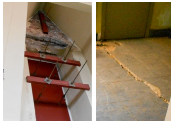
Du béton a été ajouté partout par l'occupant allemand, dans l'édifice qui se fissure.
